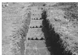
① 最下段条数分のスペースを横連結し、1m間隔で並べます。
