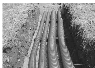
② スペースの溝に添って管を布設します
