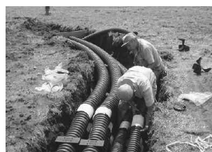
⑤ 継手は下段から順に接続します。
