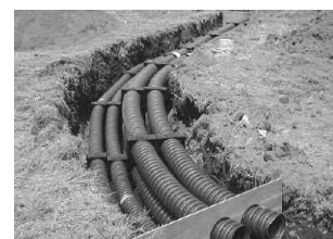
⑥ 最上段まで管を布設したら、最上段にもスペースをはめ込み、布設完了します。
