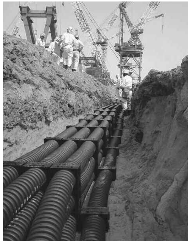
施工性とケーブル通線性を追求。 地中埋設ケーブル用多条多段配管システム。(FEP-S) JIS C 3653 管路式の管
